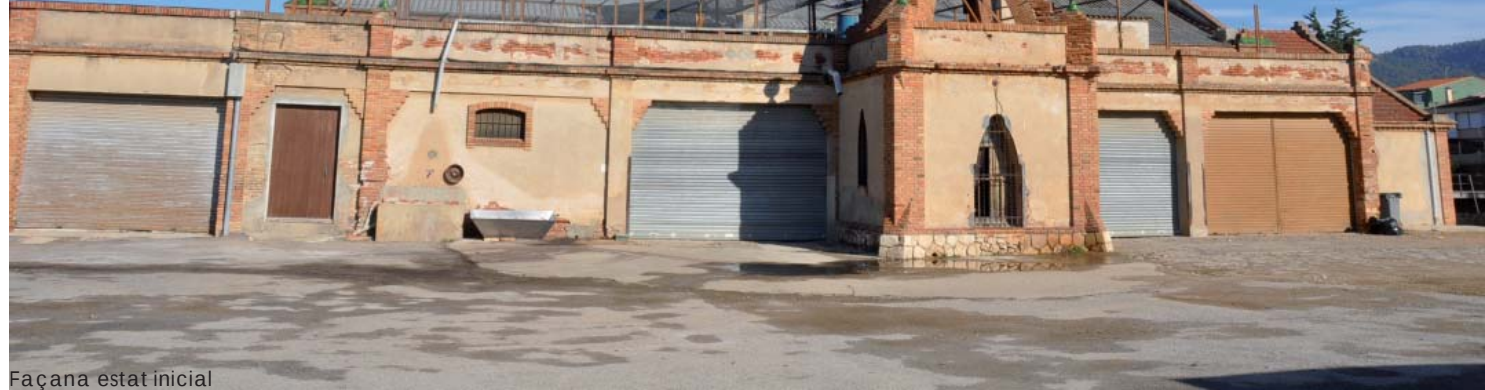
Façana estat inicial
