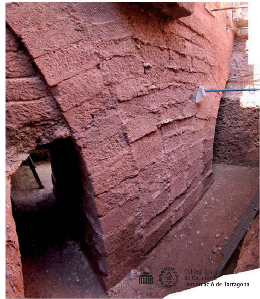
Detall de la fonamentació medieval de l'església.
